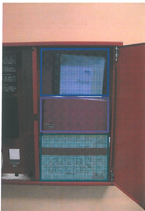
Betriebsbuch für Brandmeldeanlagen Feuerwehrpläne Feuerwehr-Laufkarten
