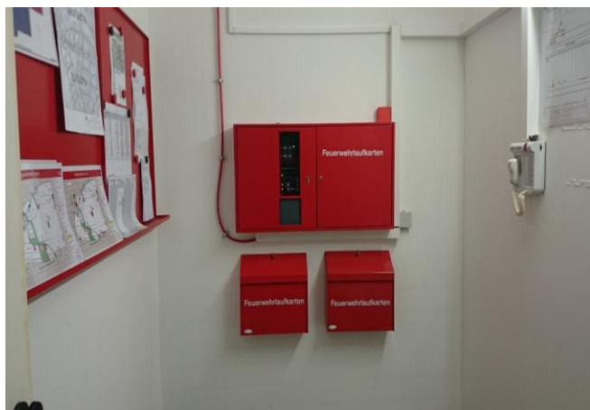
Bild 3.) Feuerwehrraum mit FIBS, Laufkartendepots und Magnet- tafel
