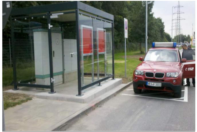
Bild 6.) Feuerwehrraum im Zufahrtsbereich eines Objektes.
