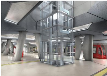
Nord-Süd Stadtbahn Köln
