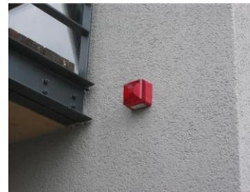
Bild: *rote Blitzleuchte oberhalb des Schlüsseldepots zur Kennzeichnung desselben*
