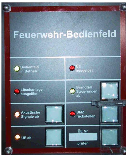
Abbildung: Feuerwehr-Bedienfeld (hier noch vor der Inbetriebnahme der BMA)
