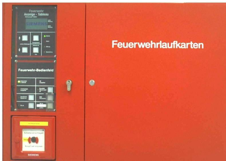
**Abbildung: Feuerwehreinformativszentrale geschlossen**
