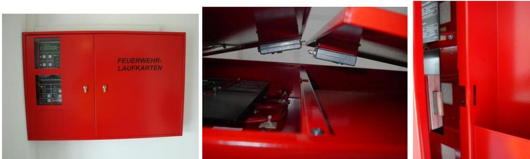
Hängeschrank mit gegenseitiger Zwangsverriegelung der Türen und Schließungen mit PHZ für die Feuerwehr. Die Größe des Schrankes ist so zu bemessen, dass die Einsatzdateien ohne Beschädigung Platz finden und die Schließung ohne Probleme funktioniert.
