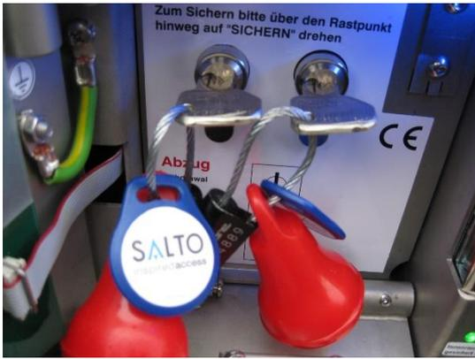
Bild 7 Überlange Schlüsselschäfte müssen eingekürzt und neu gebohrt werden, sodass ausreichend Platz zwischen Schlüssel und Umstellschloss vorhanden ist. Das Bohrloch auf der linken Seite des Schlüssels bewirkt, dass der Schlüssel auf der Stellung „Sichern“ verbleibt.
