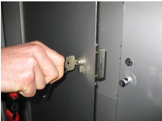
Bild 17 Die linke Tür der Erstinformationsstelle ist mit der Feuerweherschließung (PZ) gesichert. Die rechte Tür ist mit einem einfachen Schloss (CL1-Schloss) gesichert und kann durch den Betreiber der BMA geöffnet werden.
