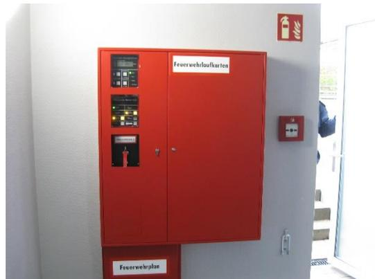
Bild 22 Der Feuerwehrplan wird, aufgrund Platzmangel in der Erstinformationsstelle, in einem separaten Blechkasten hinterlegt. Sowohl die Feuerwehr als auch der Betreiber muss Zugriff auf den Feuerwehrplan haben.
