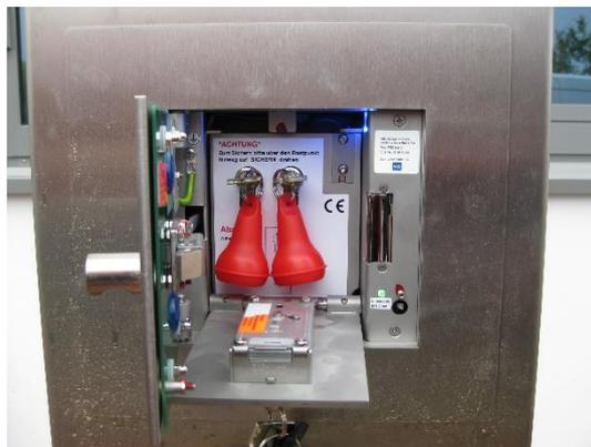
Bild 6 Das Feuerwehrschlüsseldepot ist mit zwei Profilhalbzylindern und zwei gleichen Gebäudeschlüsseln ausgestattet. Die Innentür ist zur Aufnahme eines Umstellschlusses vorbereitet.
