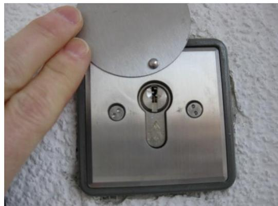
Bild 12 „FSE-Typ Profilhalbzylinder“ im eingebauten Zustand.
