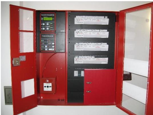
Bild 15 Erstinformationsstelle im geöffneten Zustand. Der Feuerwehrplan (roter Ordner) ist auf der rechten Seite einfach nur eingestellt. Die Feuerwehraufkarten sind gut sichtbar angeordnet.
