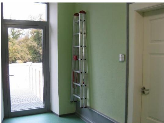
Bild 29 Ordnungsgemäß angebrachte Leiter gemäß Planung BMA in unmittelbarer Nähe der Zugangstür. Die Erkundungsleiter dient der Feuerwehr zum Auffinden von Brandmeldern in Zwischendecken.
