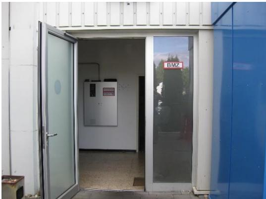
Bild 9 Das Hinweisschild mit der Aufschrift „BMZ“ kennzeichnete einstweilen den Feuerwehrhauptzugang zur Erstinformationsstelle, bei bestehenden Brandmeldeanlagen.
