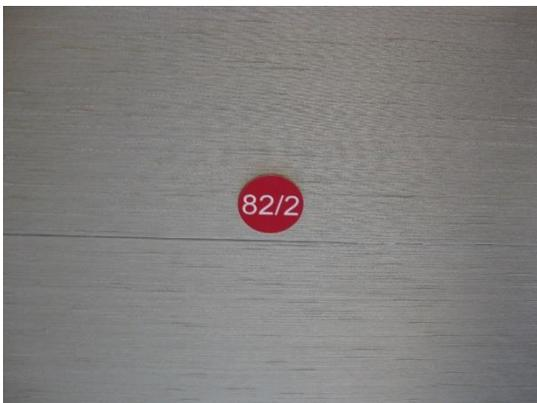
Bild 27 Roter Punkt zur Kennzeichnung von Deckenplatten oder Revi-Klappen, hinter denen Brandmelder in Zwischendecken verbaut sind. Auf dem roten Punkt sind gleich die Nummern der Meldergruppe und des Brandmelders eingraviert.
