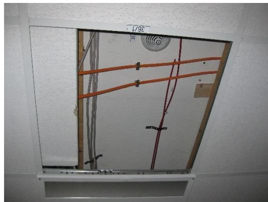
Bild 28 Deckenplatte mit einer Mindestgröße von 0,6 m x 0,6 m.
