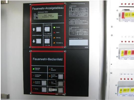
Bild 19 Im linken Teil der Erstinformationsstelle befindet sich das Feuerwehranzeigetableau (FAT) und das Feuerwehrbedienfeld (FBF).
