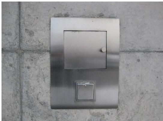
Bild 1 Feuerwehrschlüsseldepot (oben) mit Freischaltelement (unten) standardgemäß in einer Wand eingebaut.
