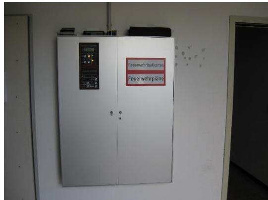
Bild 16 Erstinformationsstelle in Alu-Ausführung und ordnungsgemäßer Kennzeichnung der Feuerwehraufkarten und des Feuerwehrplanes mit Schildern nach DIN 4066 D1.
