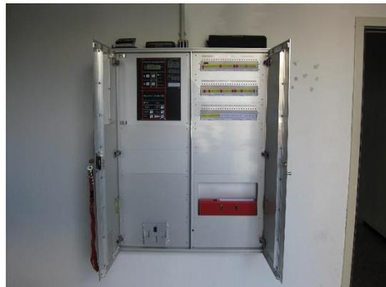
Bild 18 Erstinformationsstelle im geöffneten Zustand. Für den Feuerwehrplan ist ein Einstellfach auf der rechten Seite eingebaut worden. Feuerwehrplan und Feuerwehraufkarten müssen durch den Betreiber der Brandmeldeanlage eigenverantwortlich aktualisiert werden, sofern dies notwendig ist.
