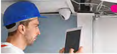
GMA: Gefahrenmeldeanlagen, Brand- & Sicherheitsanlagen
